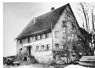
Beginn der Renovierungsarbeiten 1939
