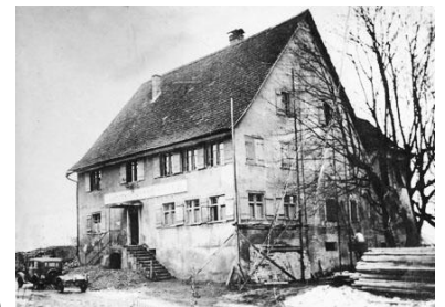
Beginn der Renovierungsarbeiten 1939
